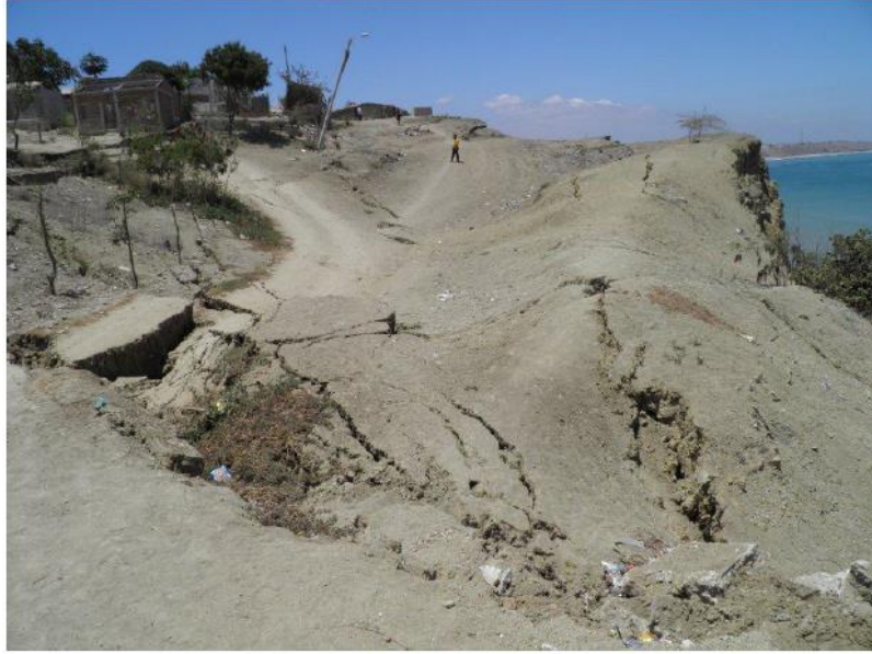
Figura 26. Fenómeno de reptación en el perfil del acantilado costero del sector 2 de Febrero.
