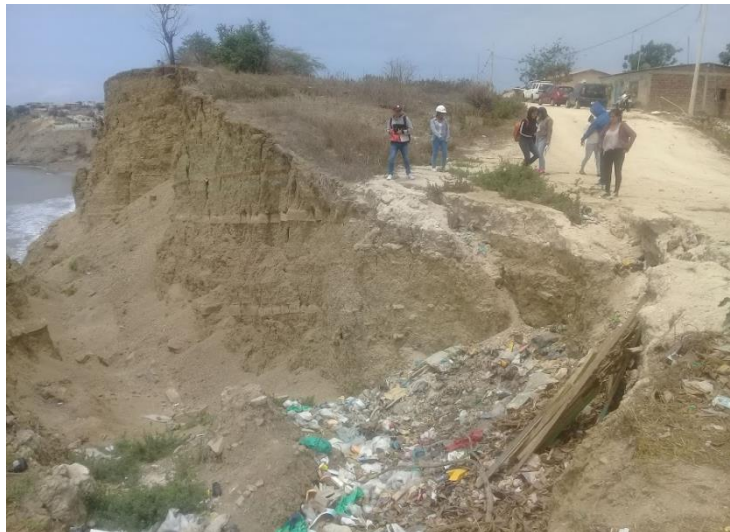
Foto 2. Escarpe de deslizamiento.
