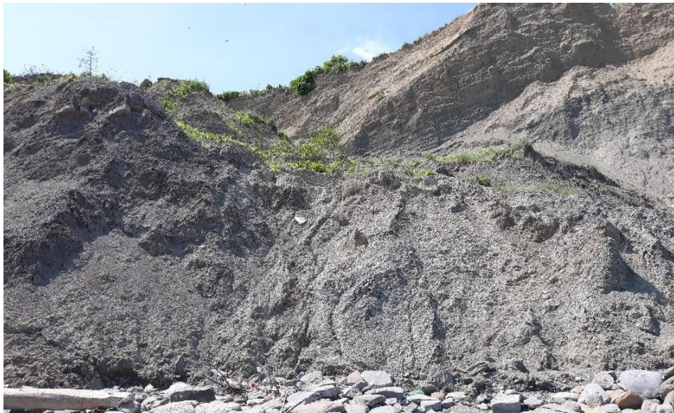
Figura 3. Deslizamiento del sector 2 de Febrero - Parroquia Anconcito, 2019. Fuente: Autores
