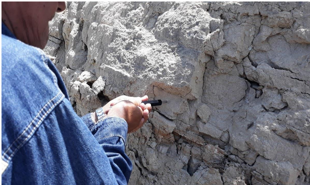
Foto 14. Medición de la resistencia de la roca con el penetrómetro – no funcionó el ensayo.
