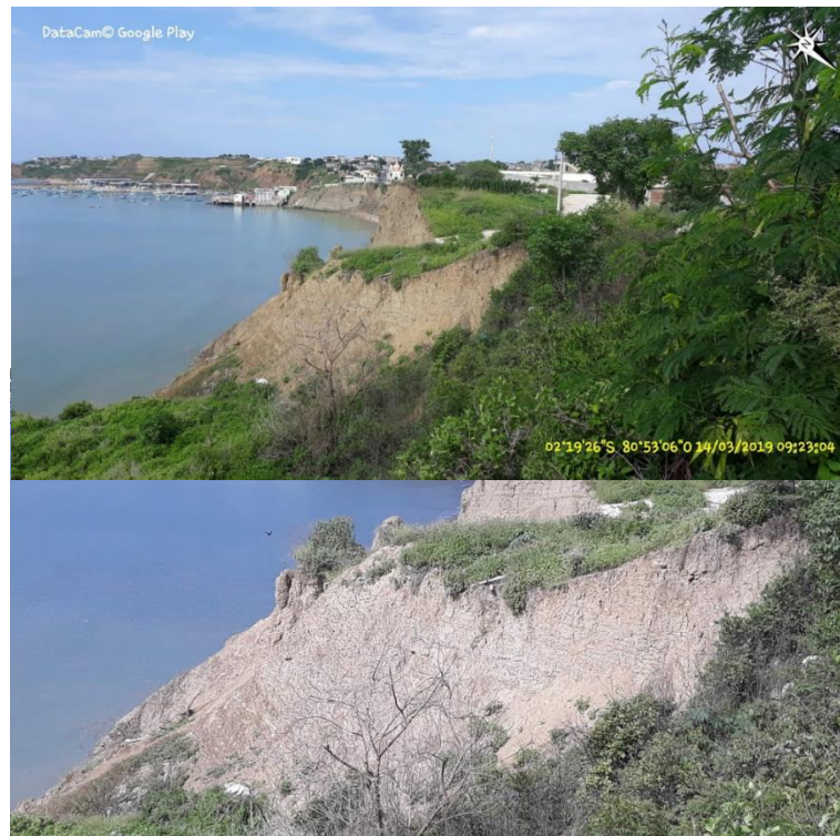
Foto 6 .Afloramiento del escarpe secundario
