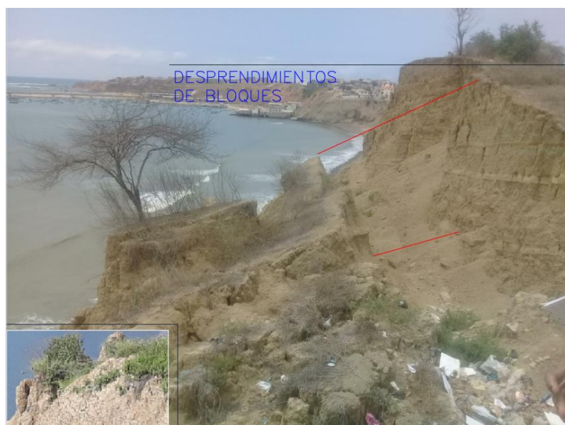
Figura 23. Desprendimientos de bloques, acantilado costero sector 2 de Febrero, 2019. Fuente: Autores
