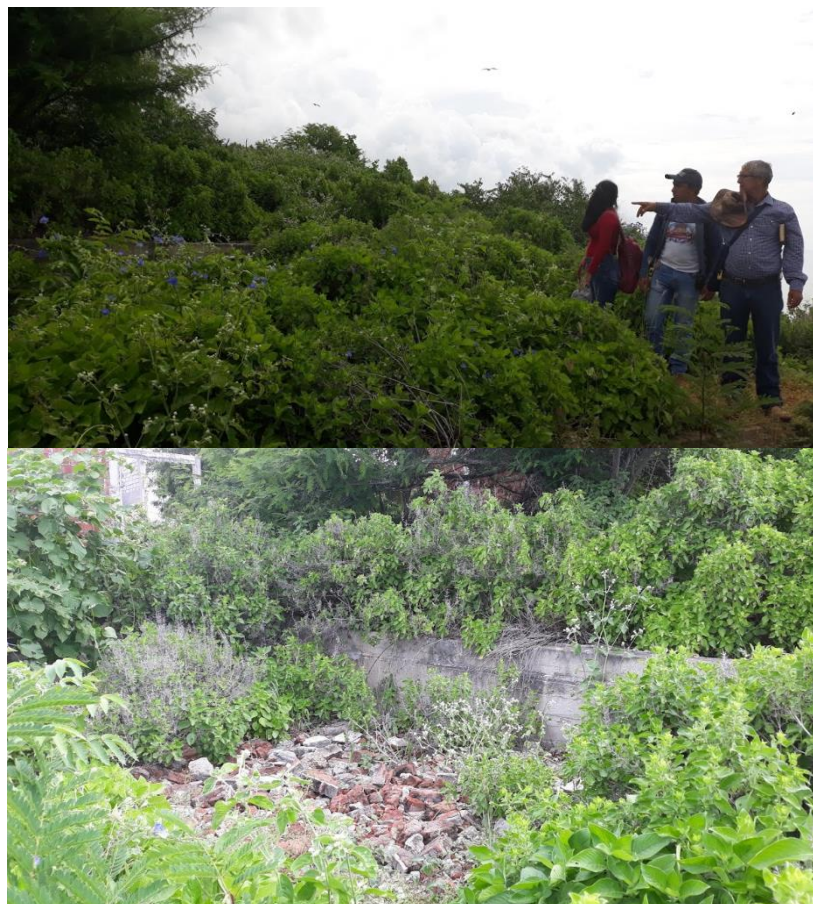
Foto 7. Escombros de una vivienda totalmente destruida.
