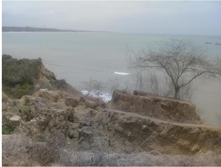
Foto 1. Desprendimientos de bloques en el talud.
