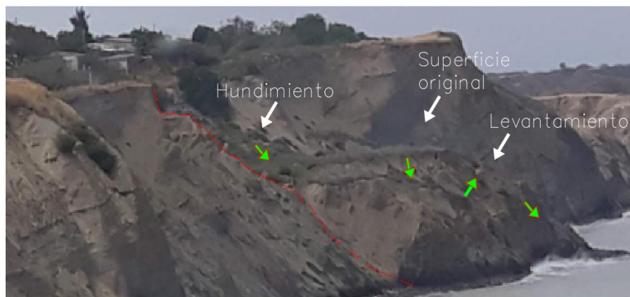
Figura 25. Deslizamiento rotacional en el sector 2 de Febrero, 2019. Fuente: Autores
