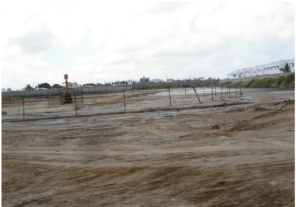
FOTOGRAFÍA N° 2.- Vista del tipo de suelo existente en el área del proyecto
