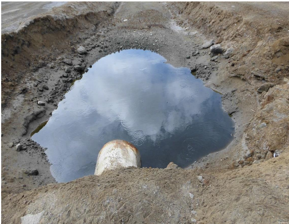
FOTOGRAFÍA N° 4.- Sistemas de alcantarilla existentes en el eje vial
