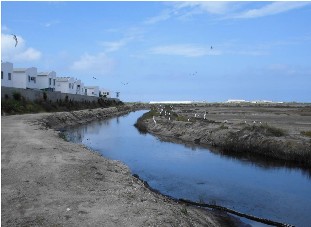
FOTOGRAFÍA N° 3.- Canales de drenaje construidos para evacuar aguas lluvias y aguas residuales
