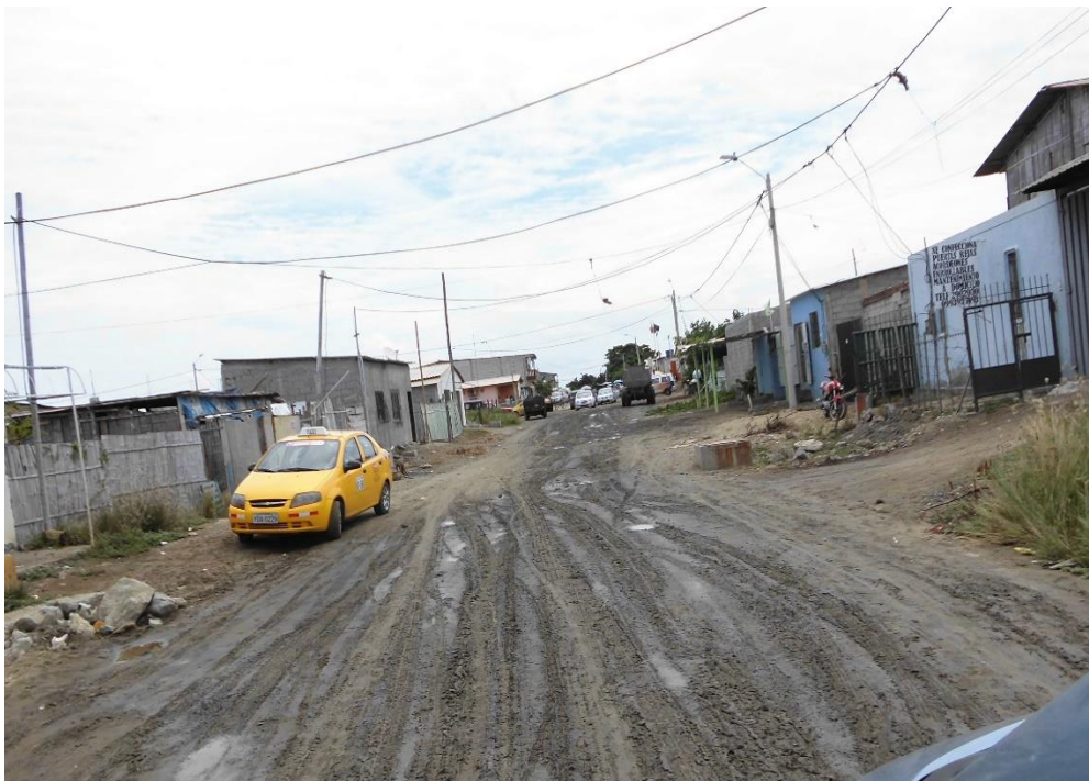
FOTOGRAFÍA N° 8.- Estado actual de las vías de acceso a la Abcisa 7+000
