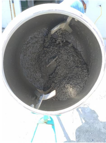
Figura 31 Mezcla del hormigón en concretera Fuente: Autores C. Soria – L. Vera
