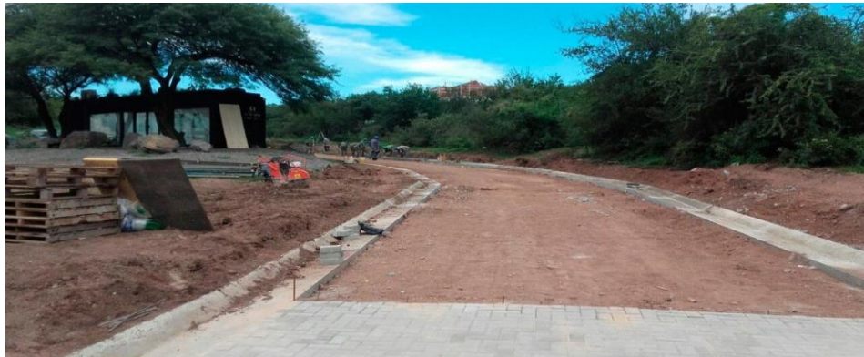
Figura 9 Cuadrilla de obreros colocando adoquín en Estancia El Terrón, Mendiolaza (Córdoba)
