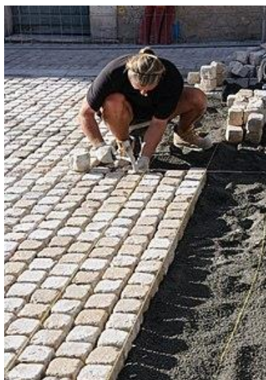
Figura 7 Colocación de adoquines en la comuna Vence Fuente: Las vías de Vence en Francia, Myrabella
