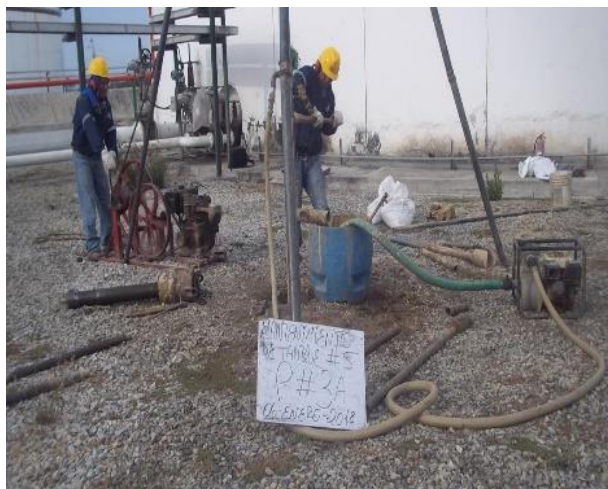
Fotografía 3. Perforación # 3 (Espotel S.A.)
