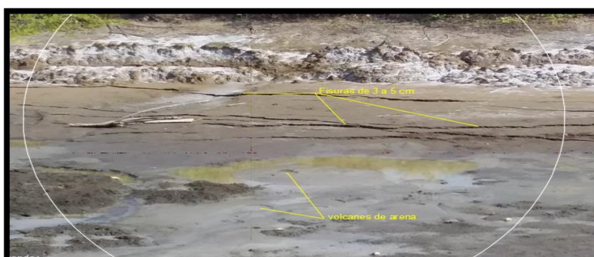
Ilustración 3. 15: Borde de camaronera Cenaim sector Comuna Palmar Barrio Sta. María se observa fisuras y volcanes de arena luego del sismo del 31 de marzo 2019 de 6.1 Mw en Salinas.
