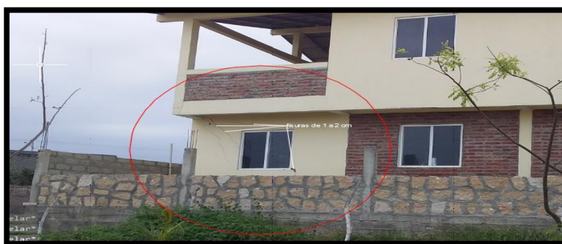
Ilustración 3. 14: Vivienda con asentamiento en el sector Comuna Ayangue luego del sismo del 31 de Marzo del 2019.
