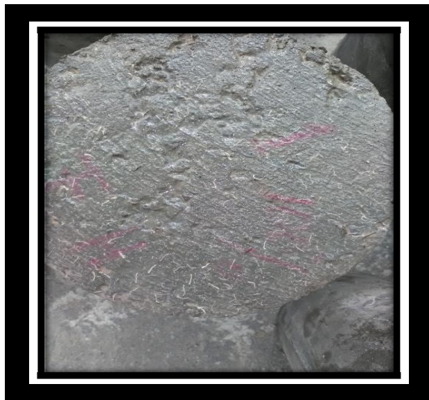
Cilindro de hormigón
