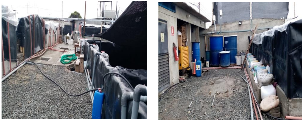
Ilustración 2 Instalaciones del Laboratorio LEASALT S.A.
