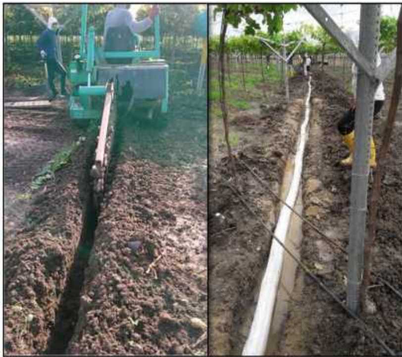
Figura 11. Zanjado e instalación de tubería subterránea
