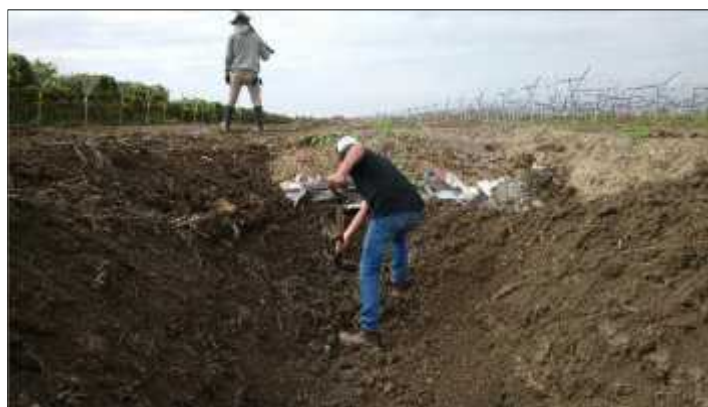
Figura 9. Mantenimiento de los drenes, desbloqueo de tuberías principales
