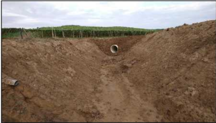
Figura 10. Mantenimiento de canales principales
