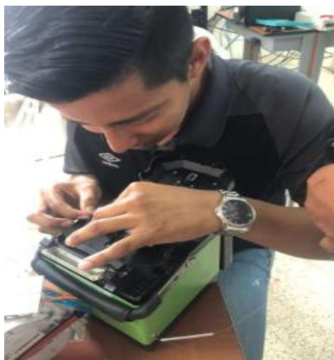
Anexo 3. Fusiones realizadas en el ODF y verificación de datos ópticos.
