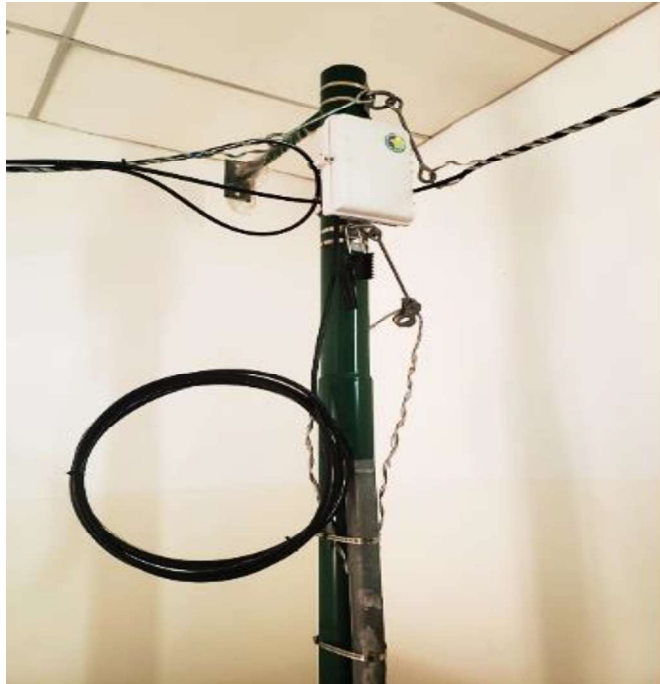
Figura 41. Reserva del tendido aéreo. Imagen tomada del proyecto.
