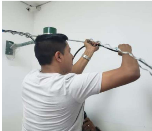
Anexo 5. Colocación de preformados para fibra ADSS aéreo.
