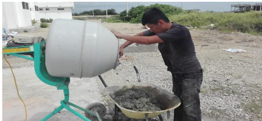
**Figura 26:** Mezcla de los elementos del hormigón
