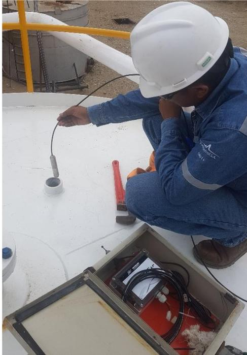
Figura 50: Instalación de sensor LH100. Autor: Orly Medina.
