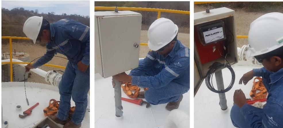
Figura 96: Instalación del dispositivo en el tanque ANC1000. Autor: Orly Medina.
