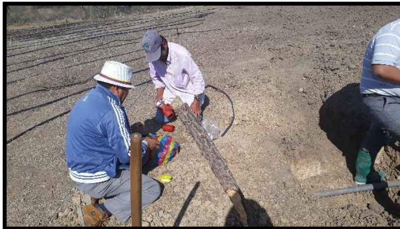
Figura 12A. Instalación de sistema de riego por aspersión, Río Verde.
