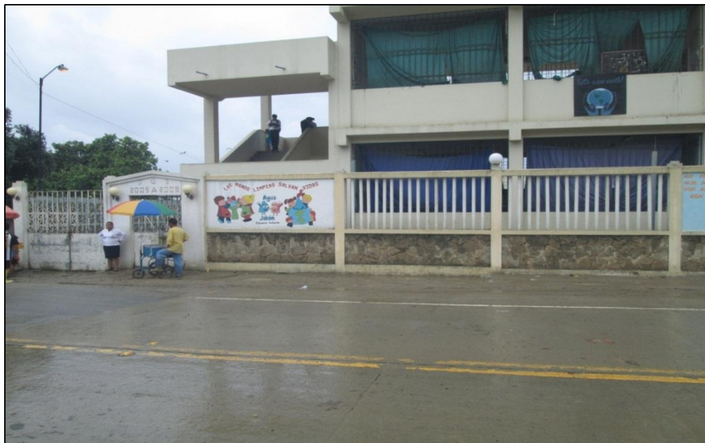
VISTA PRINCIPAL DE LA UNIDAD EDUCATIVA JULIO REYES GONZÁLEZ EN LA AV. PRINCIPAL DE INGRESO A SAN PEDRO
