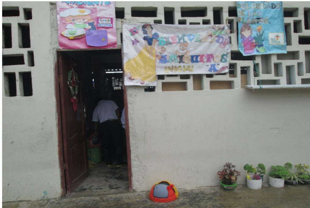
VISTA PRINCIPAL DE LA ENTRADA AL AULA DE NIVEL INICIAL DE LA UNIDAD EDUCATIVA JULIO REYES GONZÁLEZ
