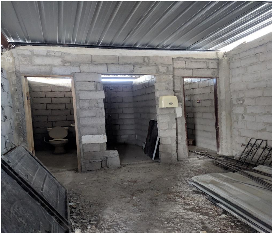
Baños en plena construcción.
