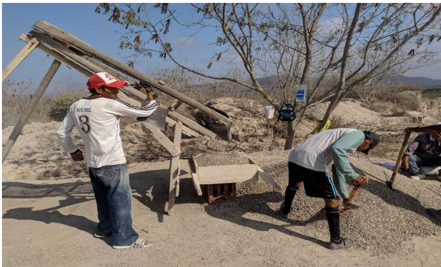
Trabajadores realizando su labor sin ninguna protección.
