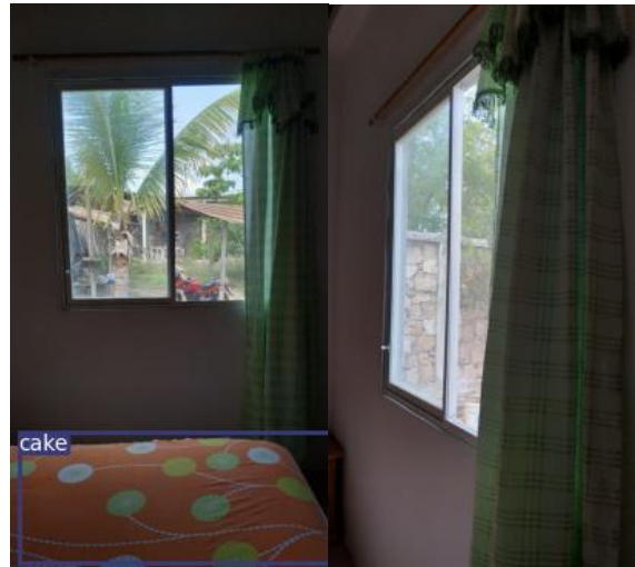
Figura 29 Ventana (Windows) Elaboración: Propia
