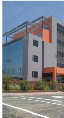
Edificio de la Consejería de la Judicatura Provincial de Santa Elena
