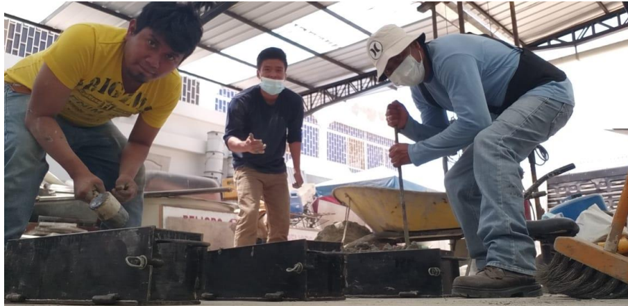
Relleno de moldes de vigas
