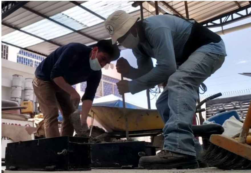
Relleno de moldes de vigas
