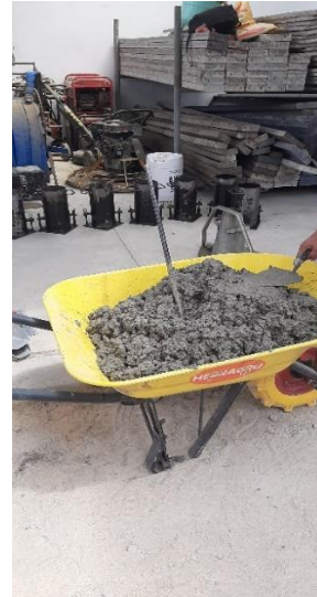
Mezcla de Hormigón
