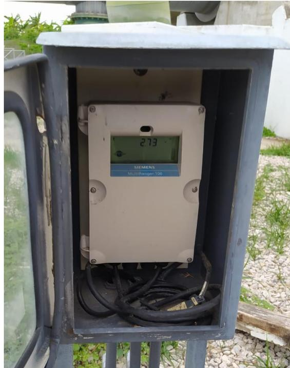
Tumbaco Lucín (2014) Dice que usando el nivel del reservorio es bajo o está por debajo del nivel 2.50 provoca que el sistema de bombeo no funcione normalmente, puesto que el suministro de agua es insuficiente debido a que existe una altura de aspiración excesiva o que el NPSHD de la instalación sea insuficiente, ocasionando que en el rodete exista demasiado vacío que excede la presión del vapor líquido, bombeado y formando burbujas (vapor o gas) a este efecto se lo denomina cavitación.
