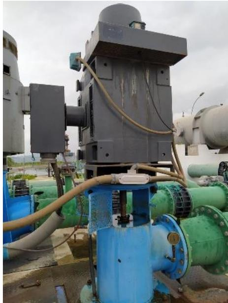
Actualmente el sistema instalado presenta problemas de cavitación por una mala condición de entrada de agua en la etapa de succión, la cual es la etapa más crítica en el bombeo, sobre todo en este caso de tener succión negativa, ya que cualquier entrada de aire producirá problemas en el sistema de bombeo.
