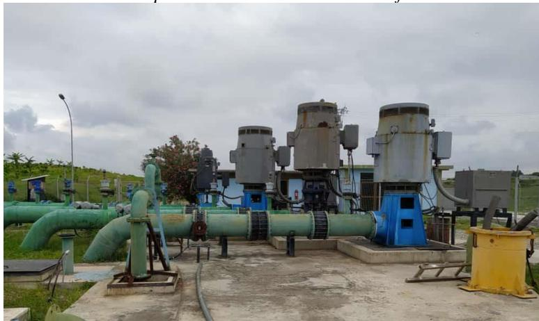
Uno de los principales problemas que surgen en las bombas es cuando el nivel del reservorio está por debajo del nivel mínimo, por lo tanto en los pozos húmedos donde se sumergen las bombas sufren variaciones de niveles de máxima eficiencia, y cuando este llega a un nivel de 2.50m o menor de profundidad provoca que en las bombas exista un incremento de velocidad y esto implica un decremento en la presión del fluido en la entrada del impulsor al contactar el fluido con los alabes.
