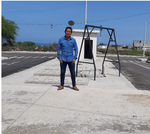
Foto #3: Caseta de Bombeo
