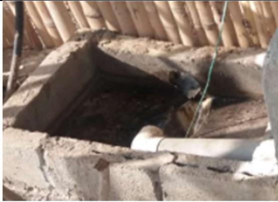
Segunda caja donde se realiza la unión de todas las tuberías para que vaya dirigida al biodigestor.
