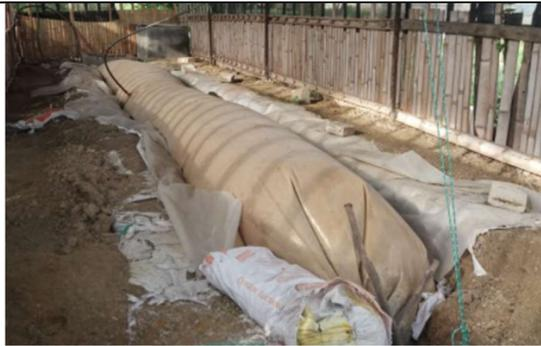
Biodigestor funcionando de forma normal a diario. Como la bolsa es plástica aunque está hecha para resistir algunas condiciones climáticas no está hecha para resistir maltratos, por lo que hay que cuidarla muy bien, recordemos que un pequeño agujero es suficiente para perder el gas y arruinar el Biodigestor por completo.
