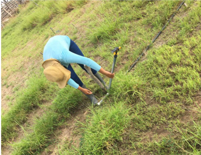
Figura 6A. Instalación de elevadores para el sistema de riego por aspersión.
