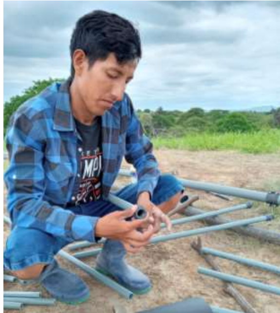
Figura 4A. Instalación del sistema de riego
