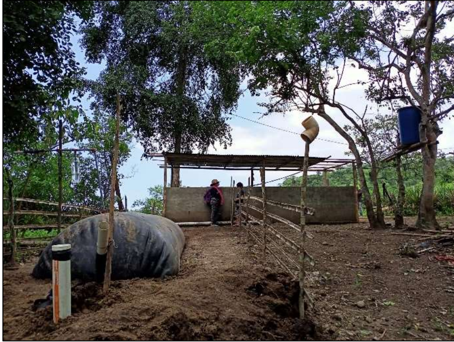
Figura 10A. Instalación de biodigestor terminada
