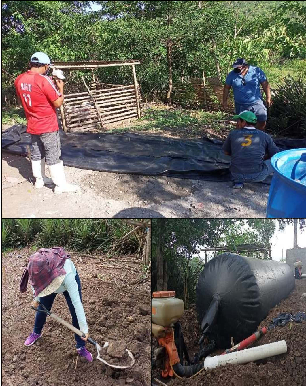
Figura 5A. Instalación de biodigestor
