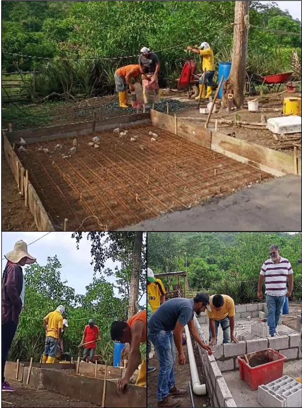
Figura 4A. Construcción de Galpón de cerdos
