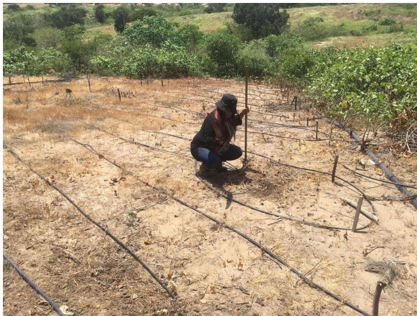
Figura 8A. Instalación del sistema de riego
