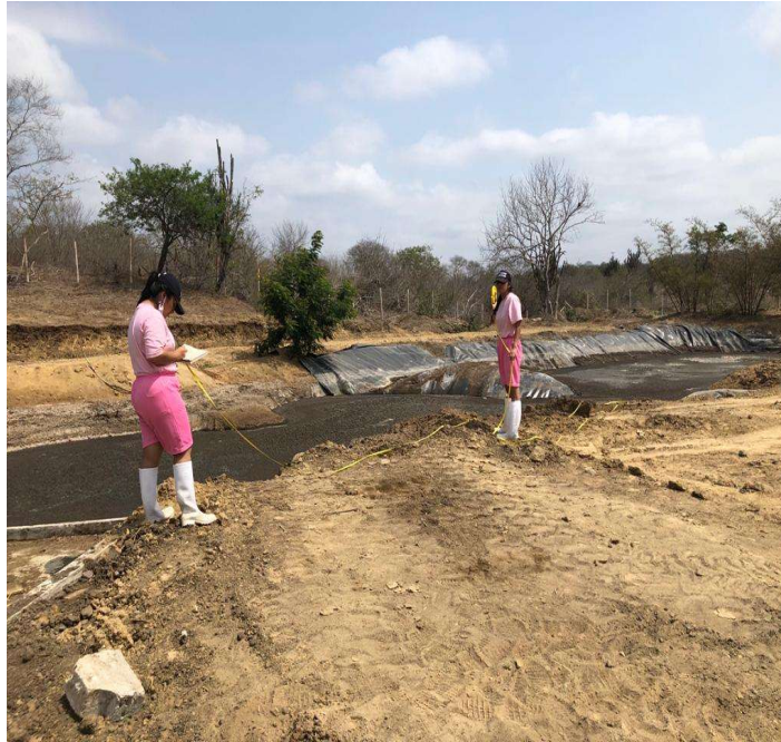
Figura 11A. Medición del área de la laguna de oxidación de sitio 1 (S1).
