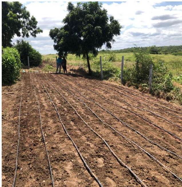
Figura 2A. Instalación del sistema de riego.
