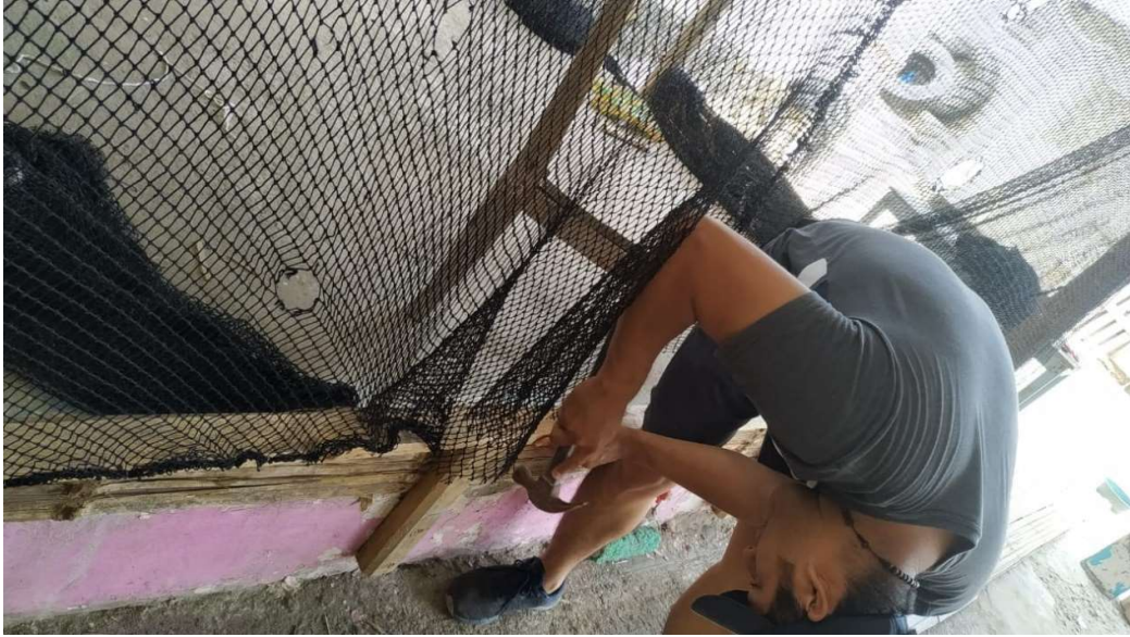
Figura 3. Cerramiento del galpón con malla.
