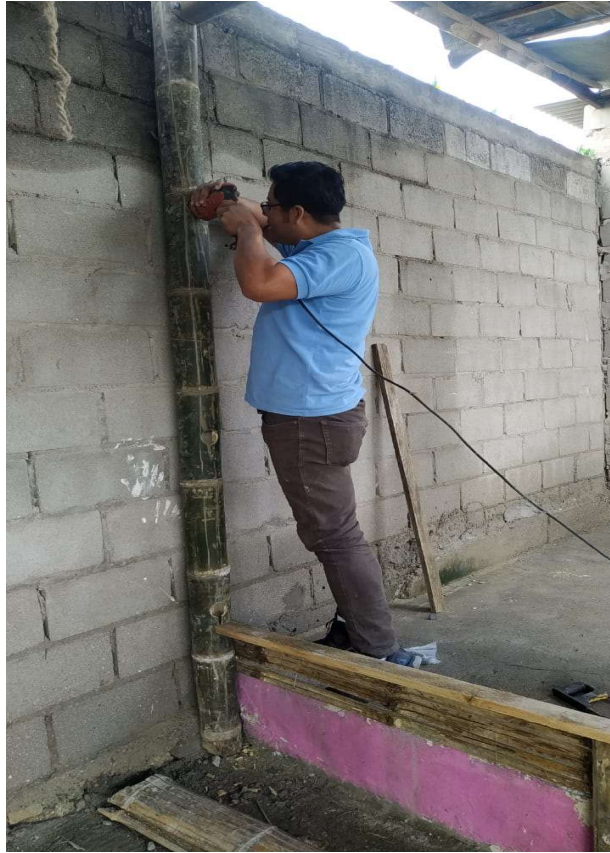
Figura 1. Construcción del galpón con cañas rollizas y picadas.
