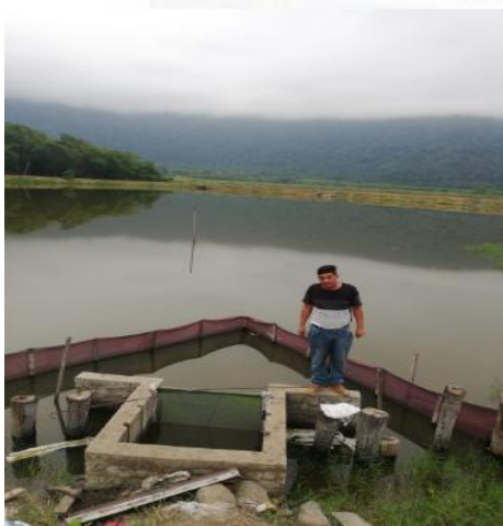
Fotografía 1 Inspección de compuerta
