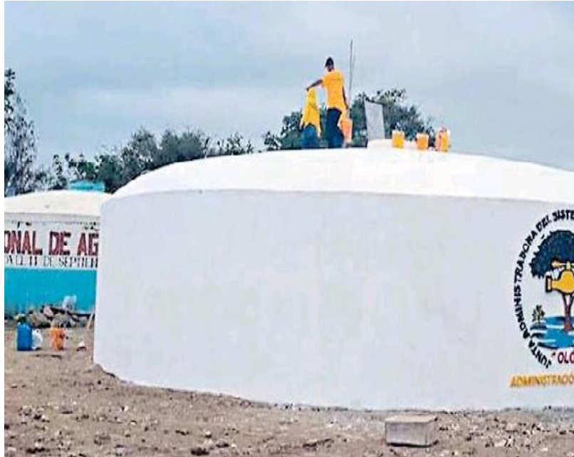
Figuras 2: Reservorio de la Junta de agua Olón
