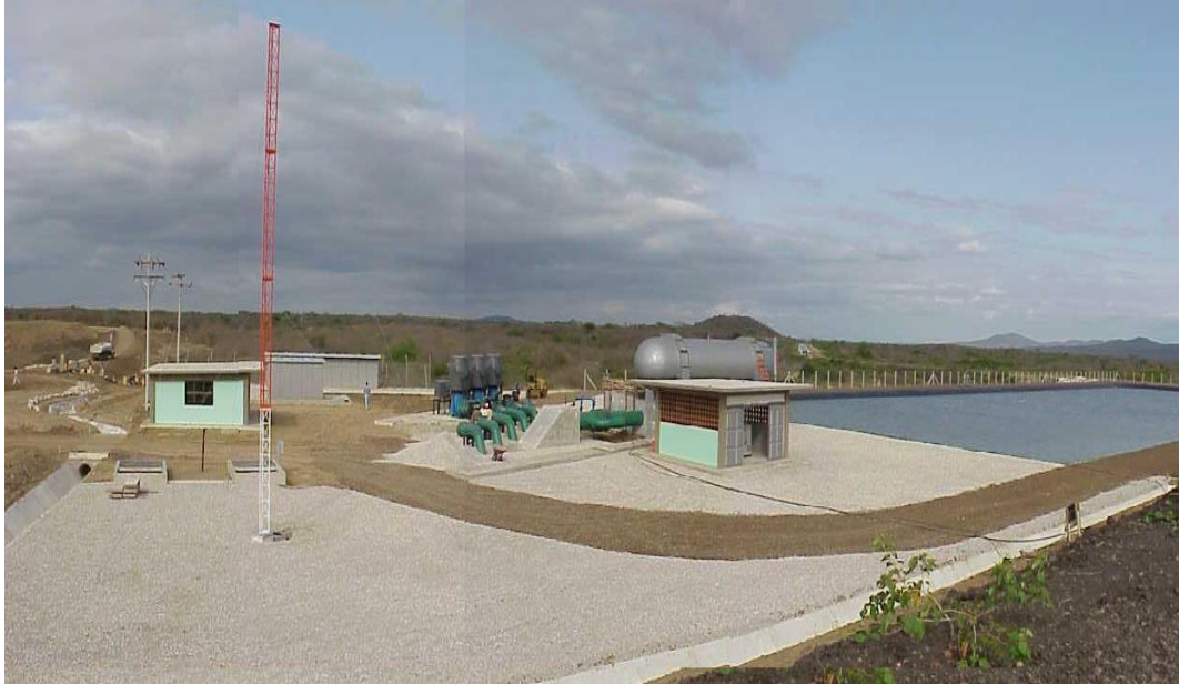
FOTO 5: BOMBEO Y TRATAMIENTO DE AGUA
