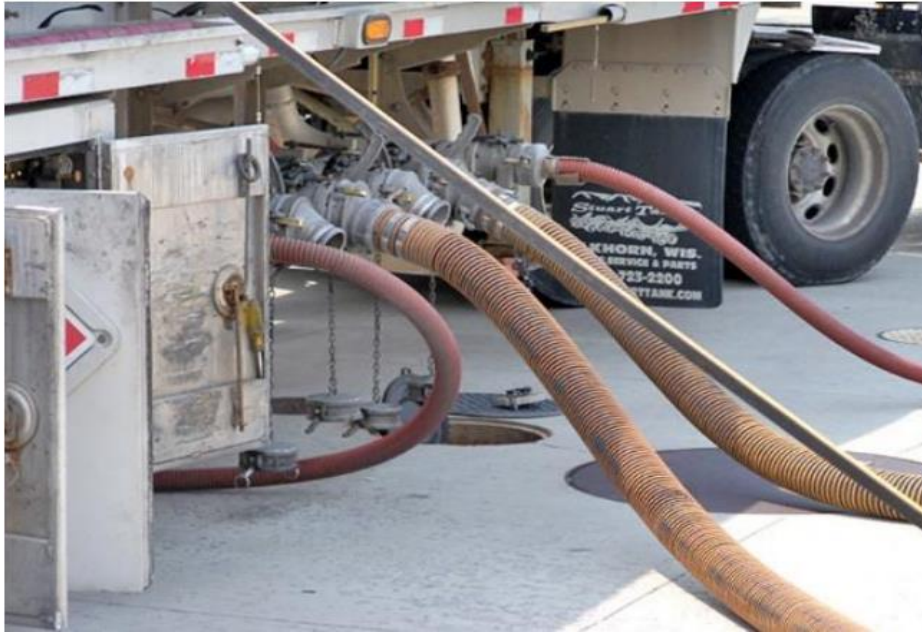
Figura 10 Mangueras utilizadas en el proceso de fracturamiento hidráulico. Fuente: Rotarydrillinghose.es.
