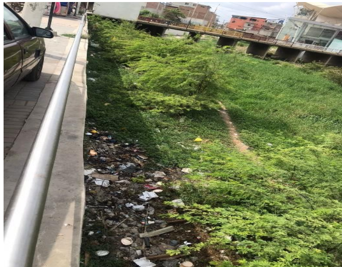
Figura 5: Desechos sólidos en el canal internacional
