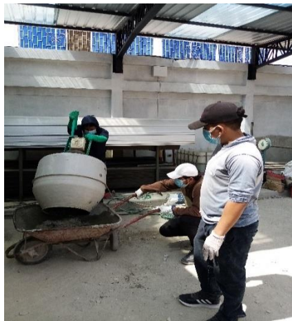
Figura 5 Vaciado de la mezcla a la carreta
