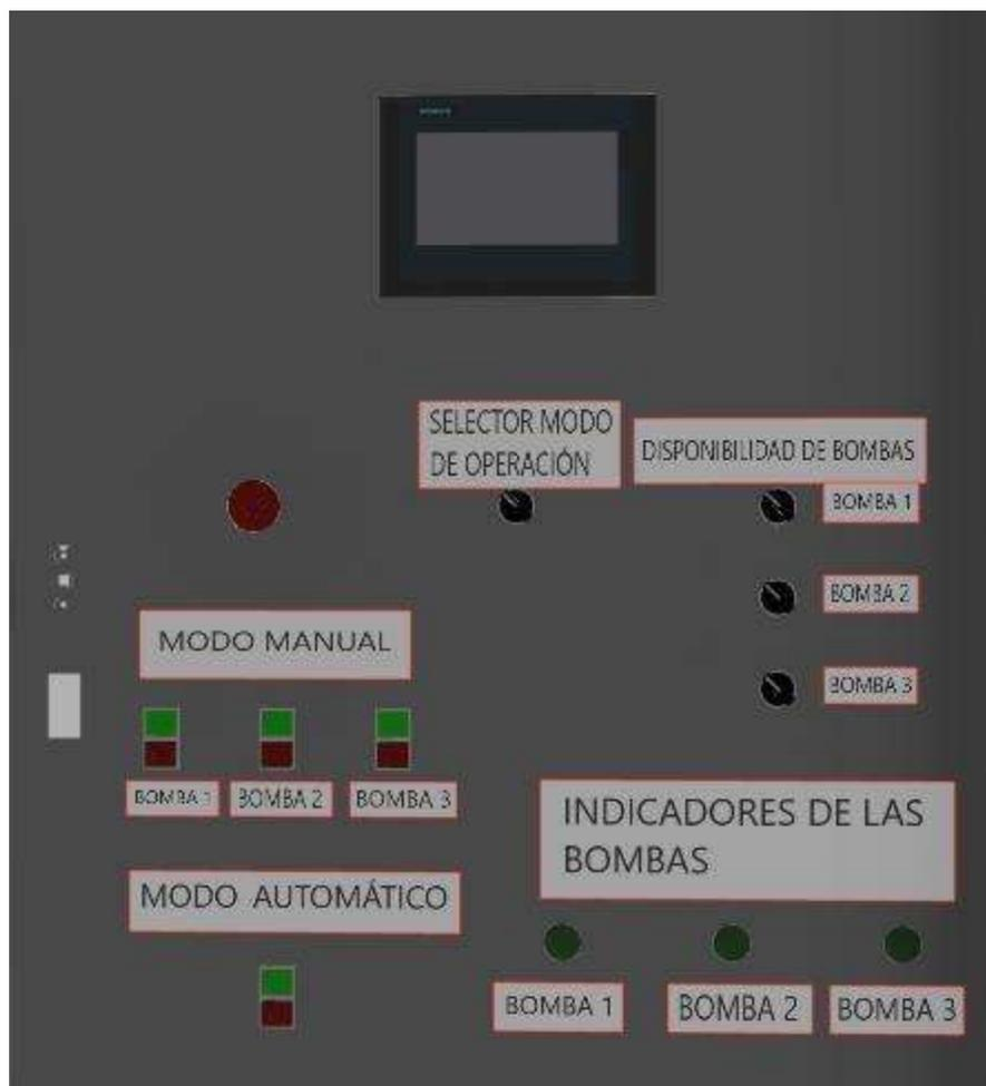
**Figura 31. Puerta de tablero eléctrico del sistema**
