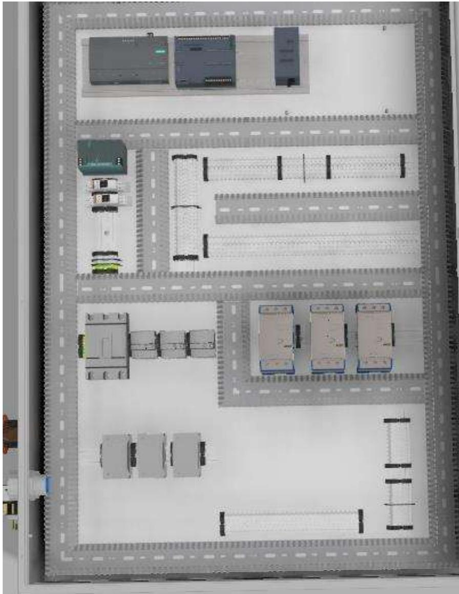
**Figura 30. Diseño interior del tablero eléctrico del sistema de bombeo**
