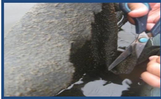
Fig # 8 Corte de una sección del geotextil
