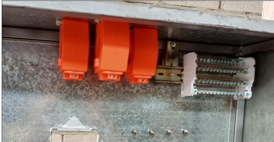
*Figura 45: Instalación final de TC's y fuente de distribución.*
