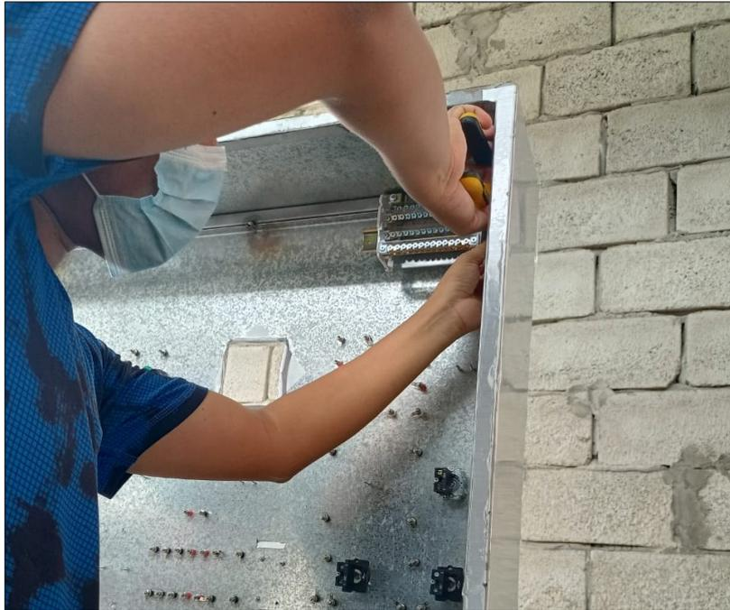
*Figura 43: Instalación interna de la fuente de distribución.*
