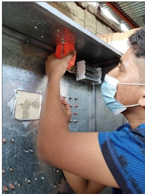
*Figura 44: Instalación interna de los TC's.*
