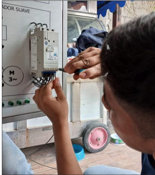
Figura 47: Conexión del arrancador suave.
