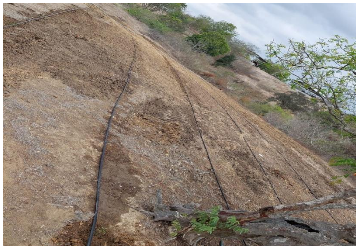
Figura 3A. Implementación de sistema de riego
