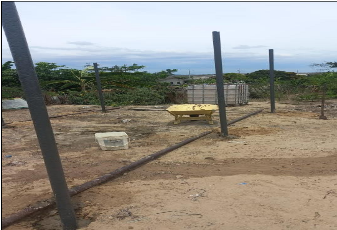
Figura 1A. Construcción del galpón para la producción de pollos broilers.
