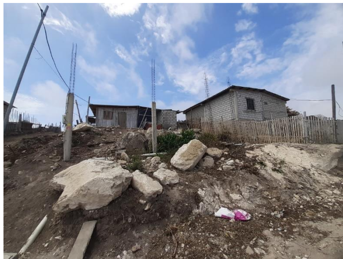
Figura 31 Evidencia de la construcción irregular de las casas en "El Tablazo"
