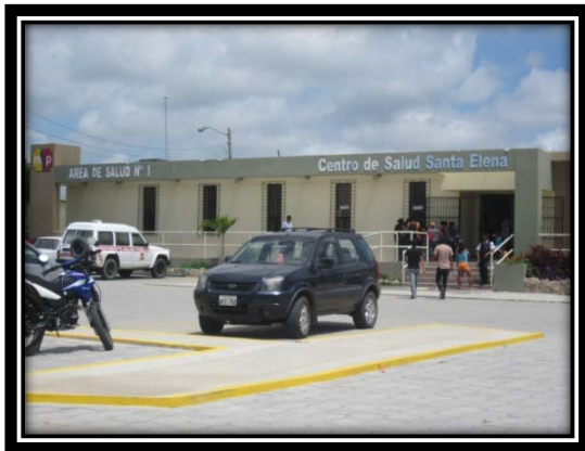
Parqueadero del Centro de Salud
