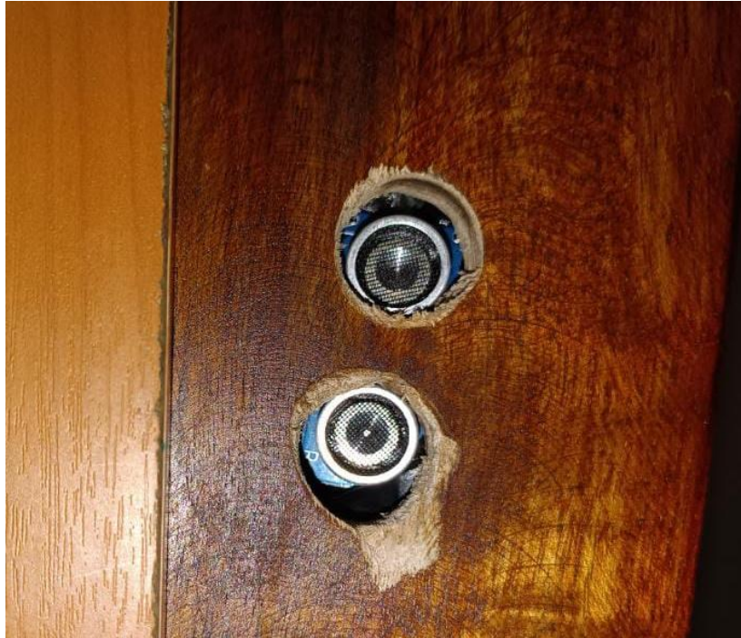
Figura 68. Conexión del medidor
