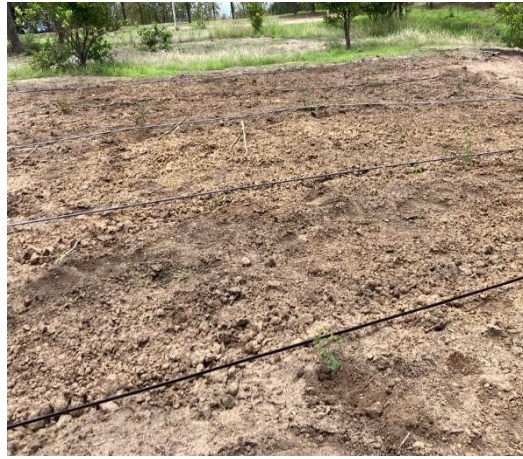
Figura 4A. Instalación de sistema de riego por goteo
