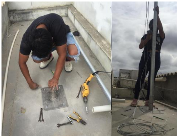
Anexo 25.- Instalación de base/sopORTE de mástil 4m. Imagen tomada por el autor
