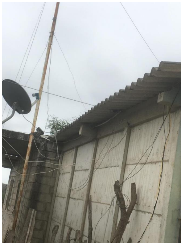
Anexo 13.- Estructura de alimentación y gestión de equipos. Imagen tomada por el autor
