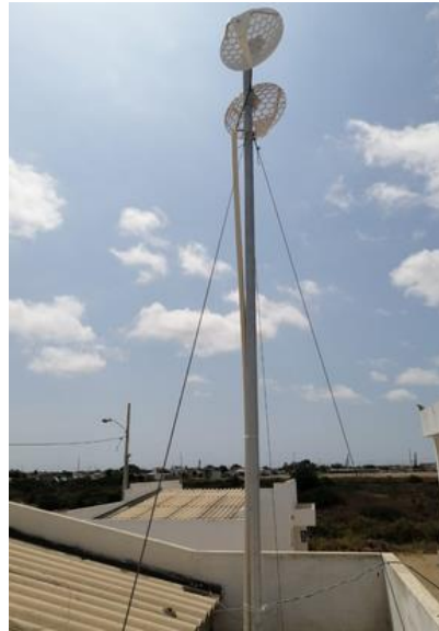
Anexo 26.- MÁSTIL 4m sobre el laboratorio de telecomunicaciones "UPSE".
