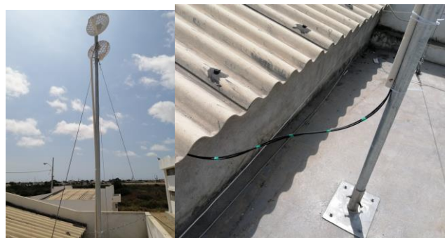
Figura 184.- Instalación de mástil sobre laboratorio de Telecomunicaciones. Imágenes tomadas por el autor.
