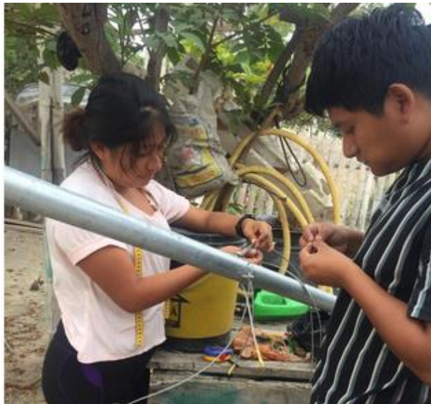
Anexo 24.- Instalación de soporte de retenidas en mástil. Imagen tomada por el autor
