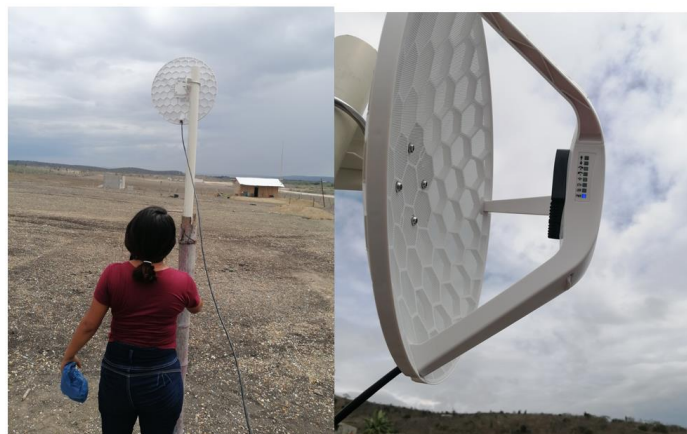
Figura 164.- Antena con localización en el punto de repetición.
