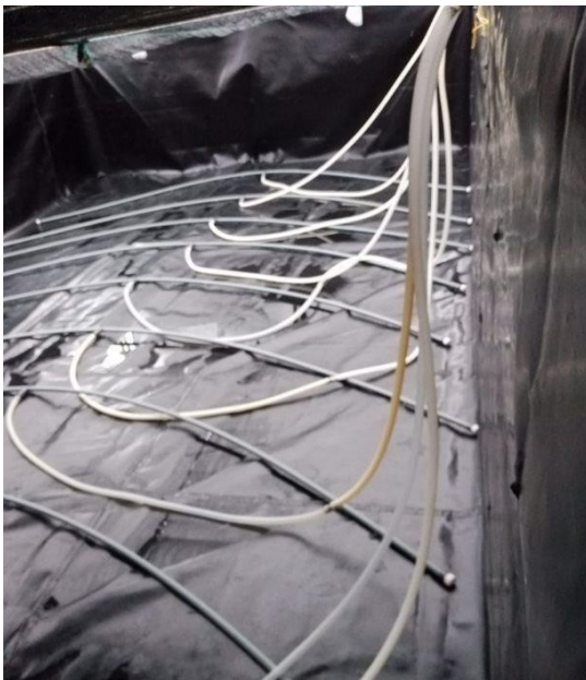
Anexo 7: Limpieza y desinfección de las líneas de aire y tuberías.
