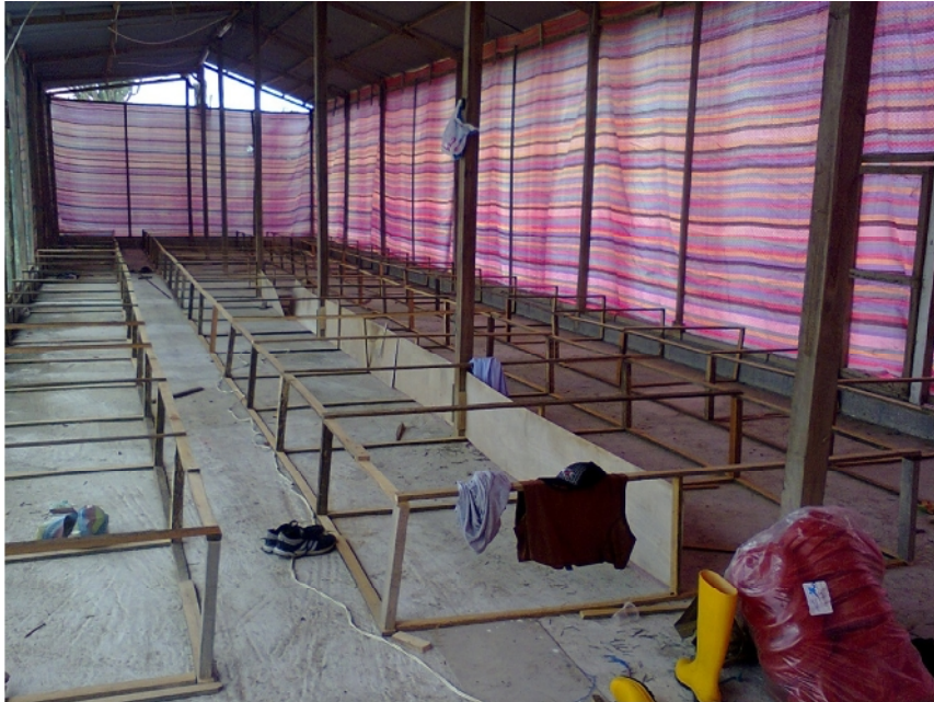
Fotografía 1. Construcción de cubículos. Febrero 2012
