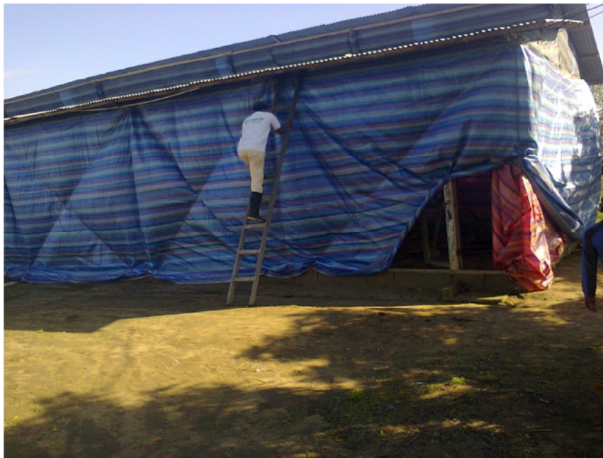
Fotografía 2. Colocación de lona. Febrero 2012
