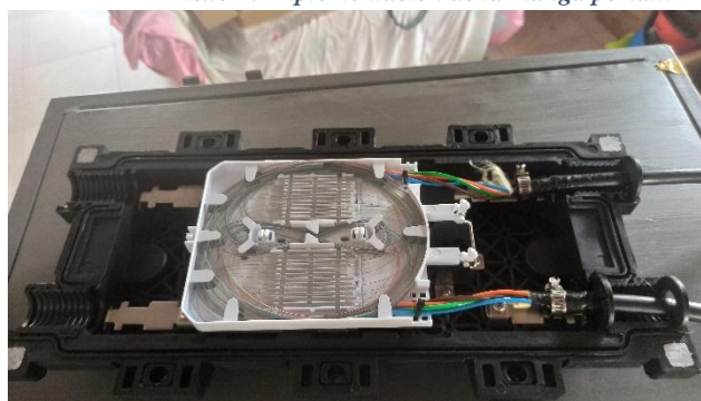
Anexo 3. Ingreso de las fibras ADSS
