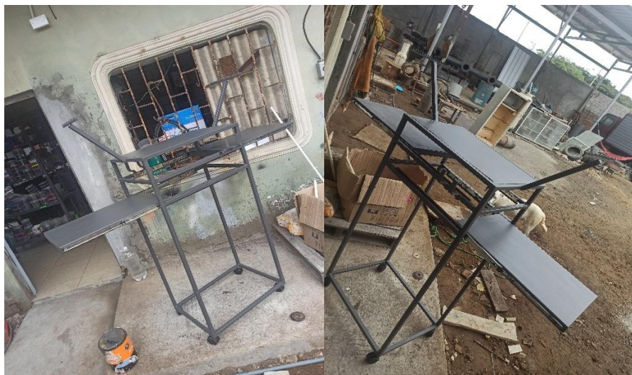
Anexo 1. Construcción de la estructura móvil
