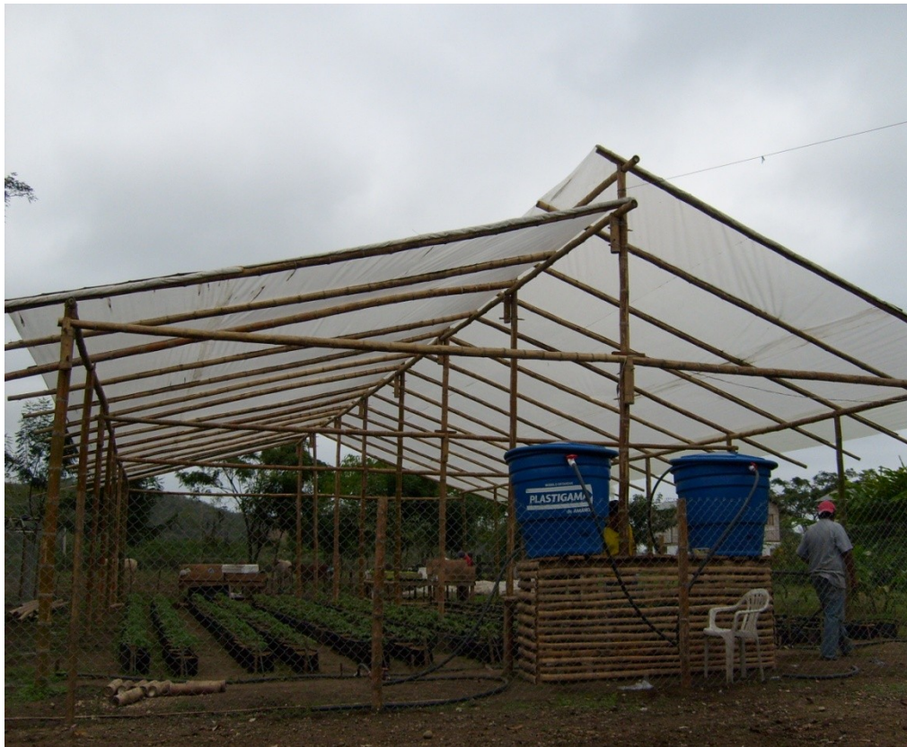
Figura 5A. Construcción de invernadero artesanal.
