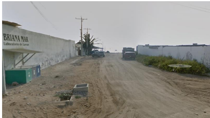
Figura 3. Vías en mal estado hacia los almacenes
