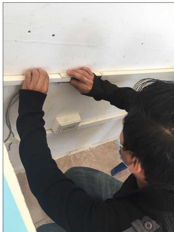
Figura 14 Tendido del cableado
