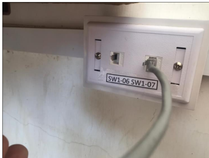
Figura 16 Identificación del cableado en las rosetas
