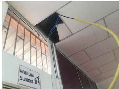
Figura 10 Instalación del cableado
