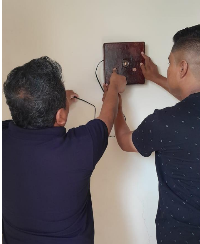
Figura 50. Instalación del prototipo
