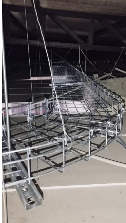
Figura 22: ubicación e instalación de la canalización Fuente: Elaborado por Autor
