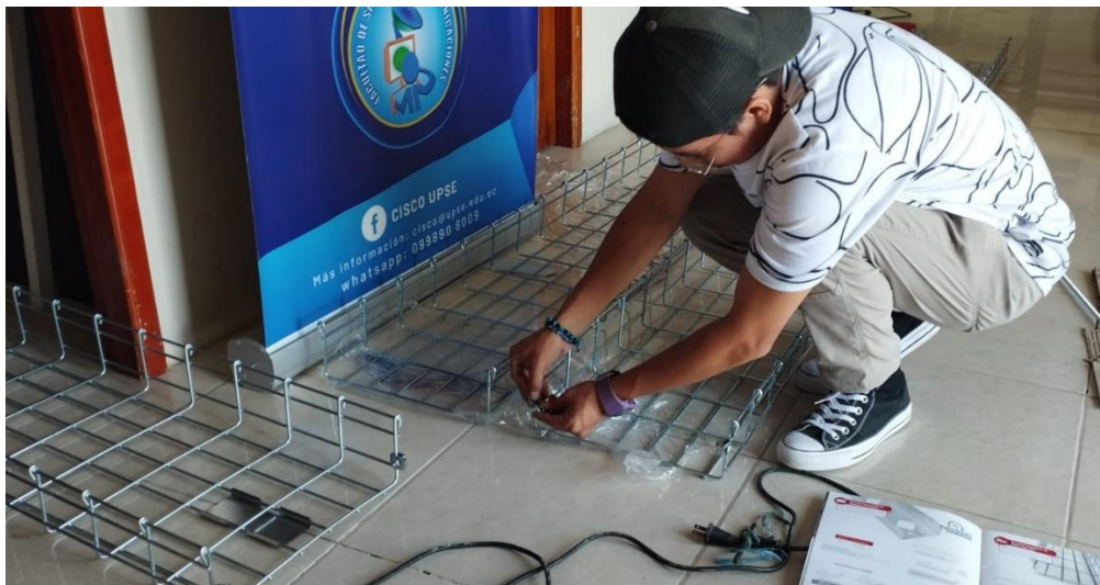
Figura 21: armado de las bandejas porta cable Fuente: Elaborado por Autor
