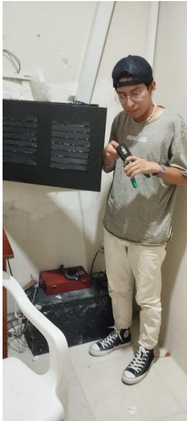
Figura 24:Proceso de Ponchado Fuente: Elaborado por autor
