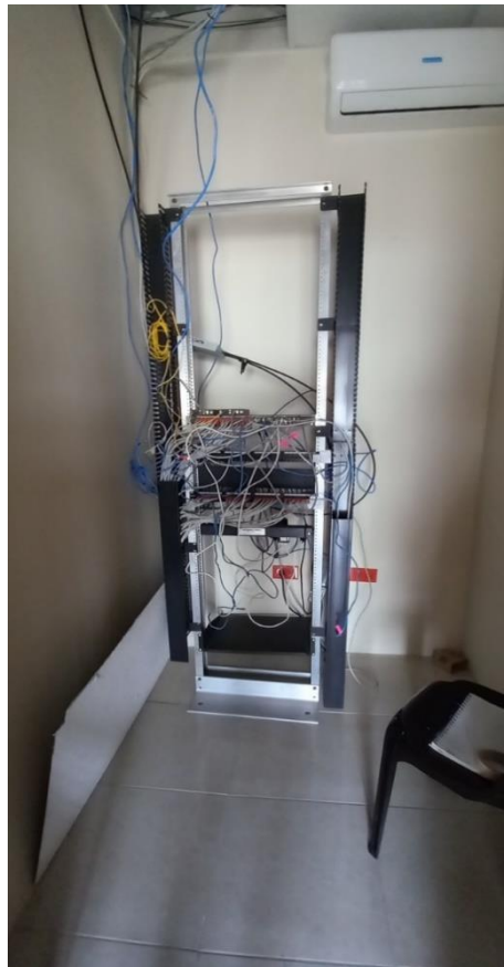
Figura 15: Centro de Distribución Intermedia Fuente: Elaborado por autor
