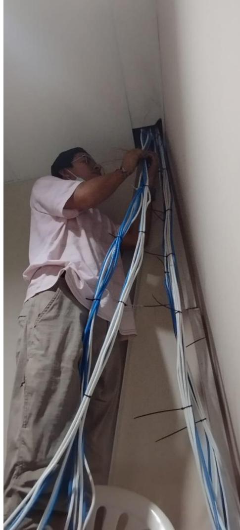
Figura 23: Tendido y peinado del cable UTP Fuente: Elaborado por autor
