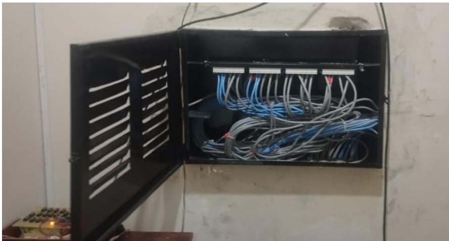
Figura 20: integración de patch panel Fuente: Elaborado por autor
