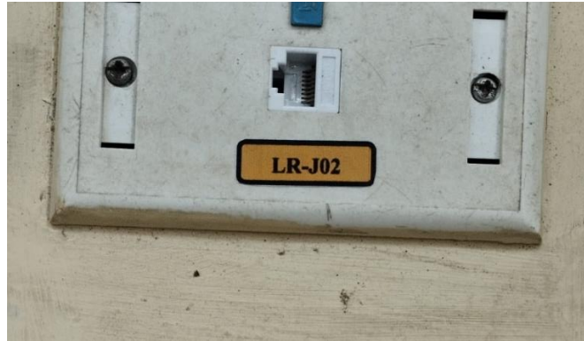
Figura 28: etiquetado del laboratorio de redes Fuente: elaborado por autor
