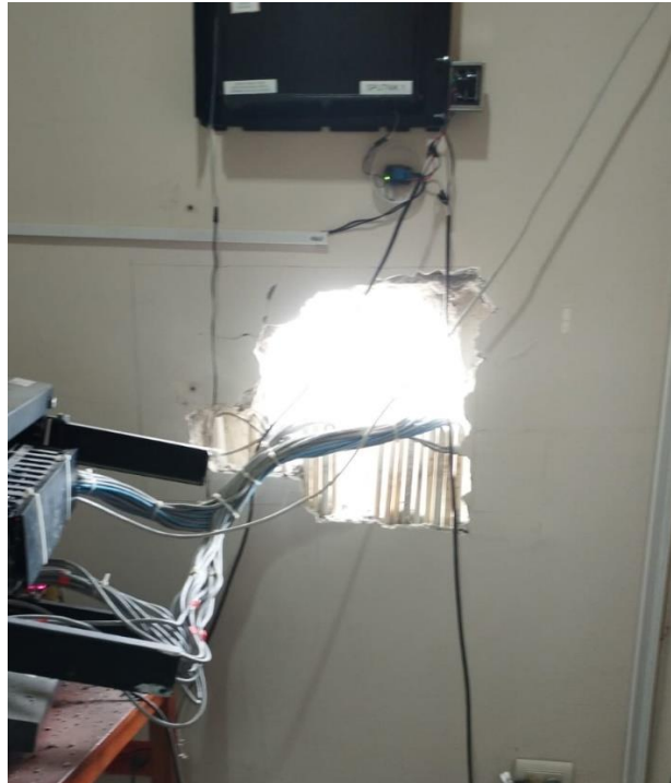
Figura 18: Desmontaje del rack de pared y revisión del estado del cableado Fuente: Elaborado por Autor
