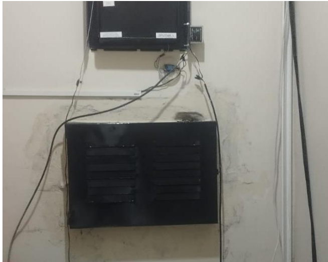
Figura 19: Montaje del nuevo gabinete Fuente: Elaborado por autor
